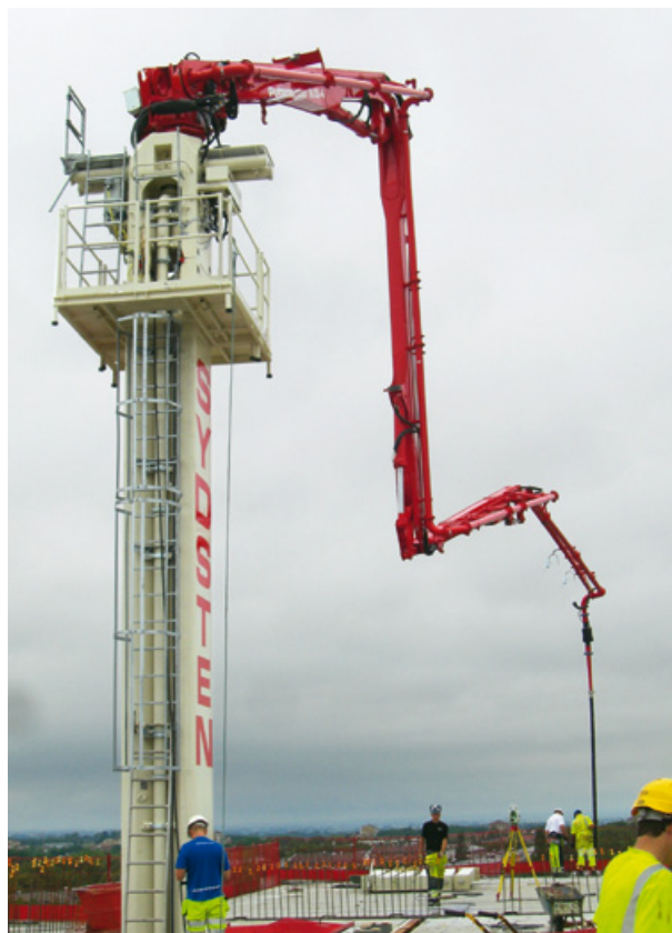
Sydstens självklättrande pumpmast effektiviserar gjutning på höga höjder.
