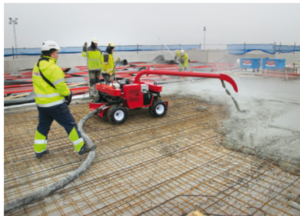
Med Line Dragon blir arbetsmiljön betydligt skonsammare för betongarbetaren och pumpmaskinisten.
