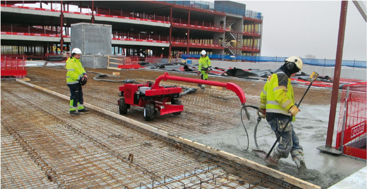
Sydstens självgående betongfördelarvagn ger effektivare gjutning och stora besparingar.
